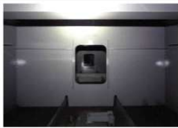
거더 내부 전경
