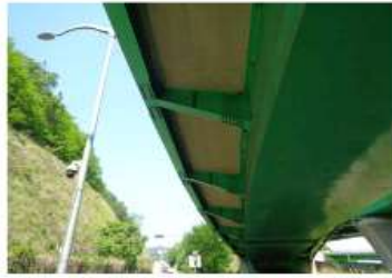
캔틸레버부 바닥판 하면 전경
