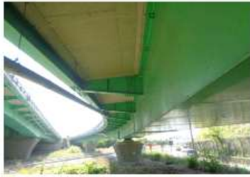
캔틸레버부 바닥판 하면 전경
